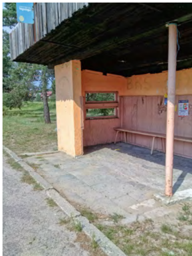
Fot. 3. Przystanek autobusowy w Długim Kącie (fot. E. Rutkowska)
