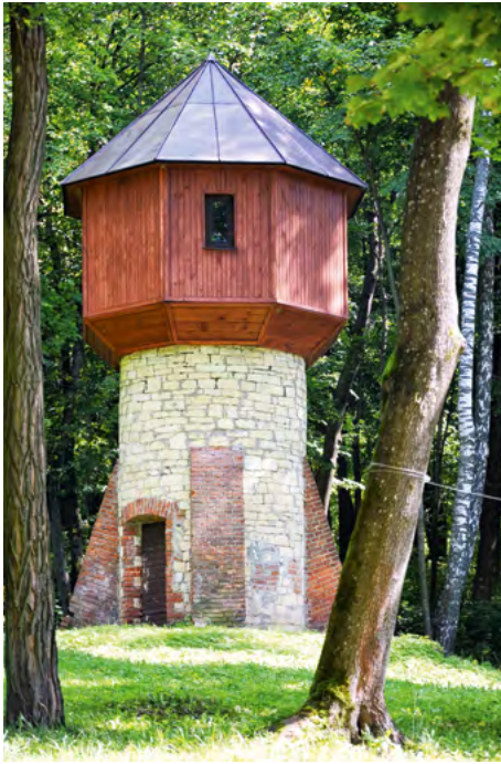
Fot. 14. Wieża widokowa w Krasnobrodzie – niedostępna (fot. E. Rutkowska)
