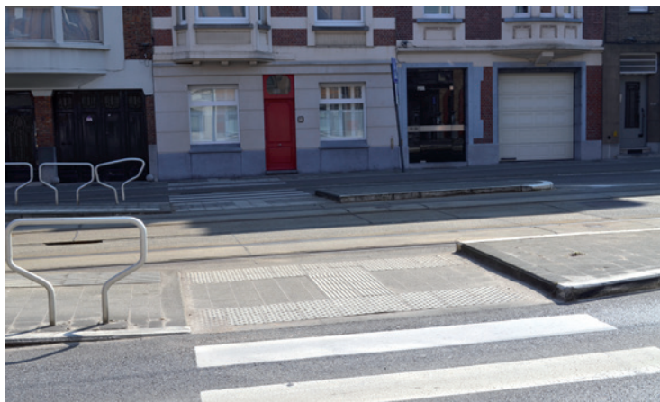
Ilustracja 2. System oznaczeń fakturowych na przejściu dla pieszych, Gent, Belgia
